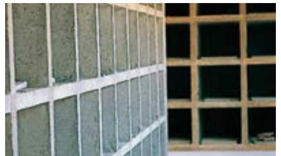
10 Szalunki na katakumby
