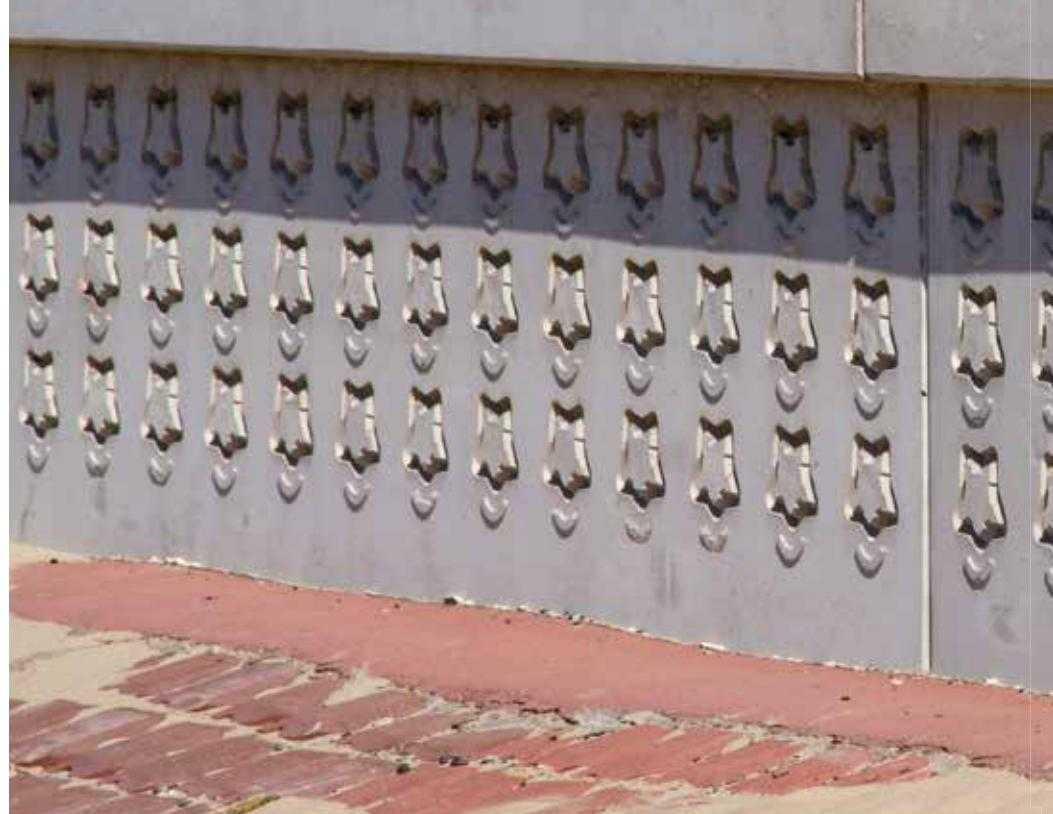
individuales puede ser necesaria la elaboración de un modelo a escala natural. Este se utiliza posteriormente para elaborar la matriz de textura propiamente dicha. Para apoyar a los arquitectos y proyectistas en su trabajo, NOE-Schaltechnik pone a disposición numerosas propuestas de diseño, que el diseñador puede utilizar tal cual, modificarlas o verlas como un estímulo creativo.
